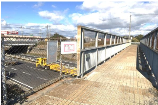
第2神明道路を渡る水路橋
