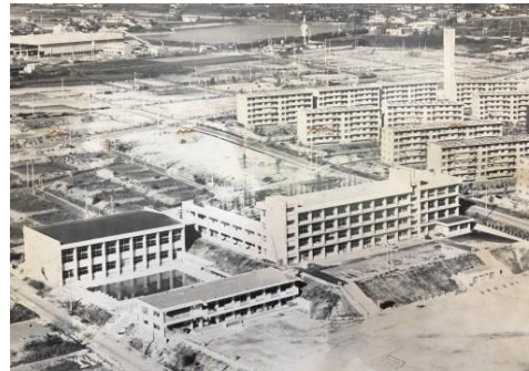
11号池(手前高丘西小学校) 昭和51年頃
